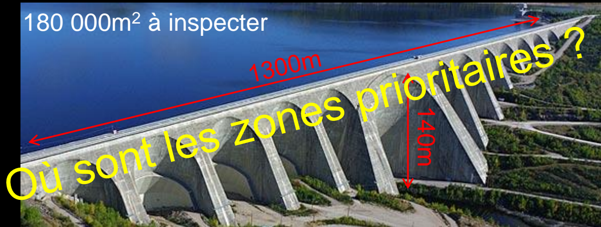
Centrale Manic-5. Photo : Hydro-Québec
